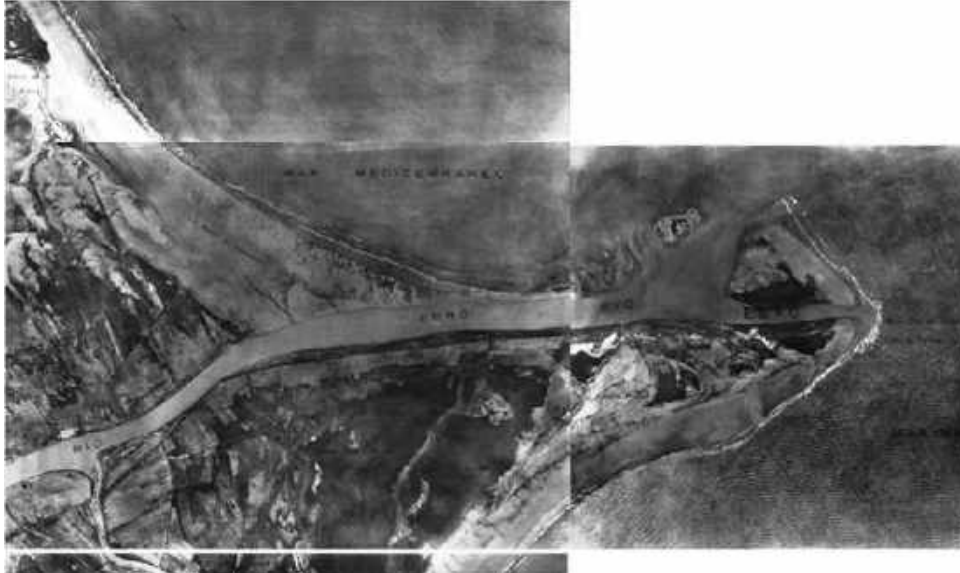
Figura 2.45: Foto de 1937 de la desembocadura del Ebro una vez cerrada la desembocadura del Cabo Tortosa (Fuente: Jefatura de Costas de Tarragona e IHAC, 2011)
