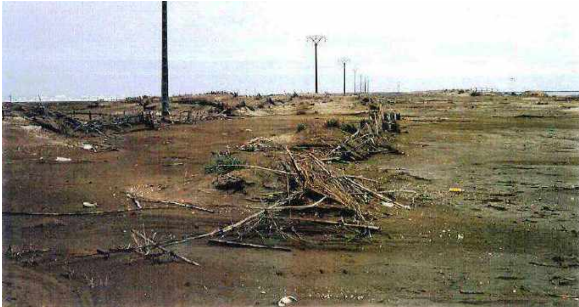
Figura 4.67: Destrucción de dunas y defensas eólicas en febrero 1996, realizadas en 1992, en la barra del Trabucador (Fuente: CEDEX, 1996)
