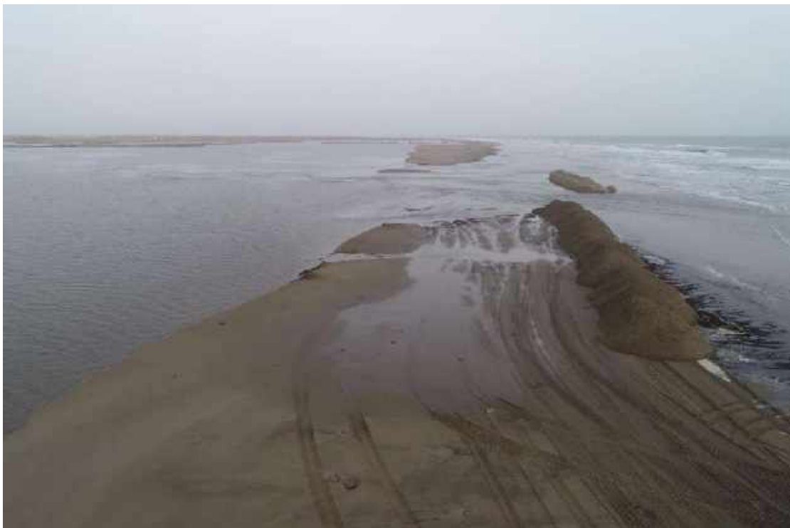
Figura 2.125: Detalle de la rotura de la barra del Trabucador tras el temporal de enero de 2020 (Foto: MITERD)
