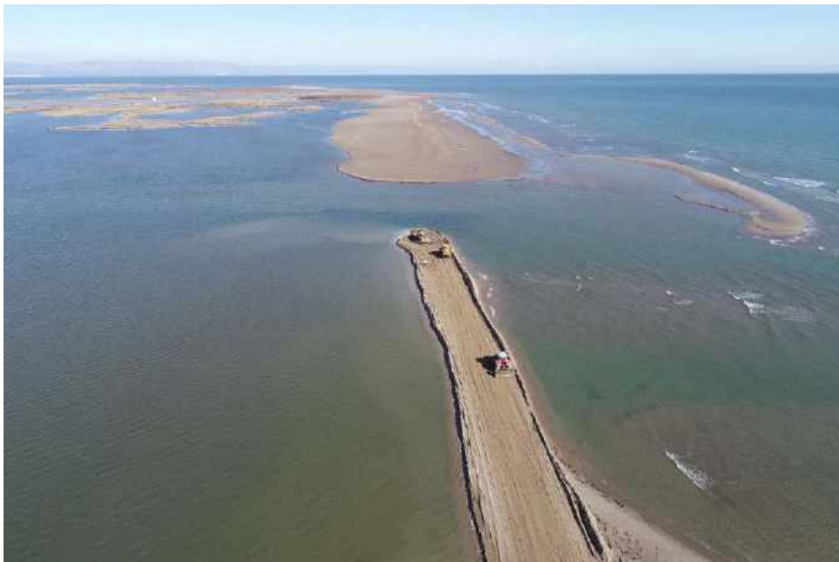
Figura 2.126: Obras de cerramiento de la barra del trabucador en febrero de 2020 (Foto: MITERD)
