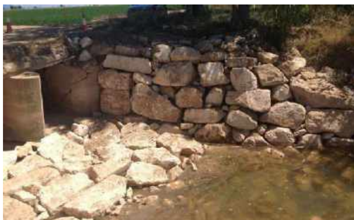
Figura 2.116: Reconstrucción de paso superior sobre canal de desagüe, en el término municipal de Deltebre (Después de las obras) en 2015 (Foto: DGCM)
