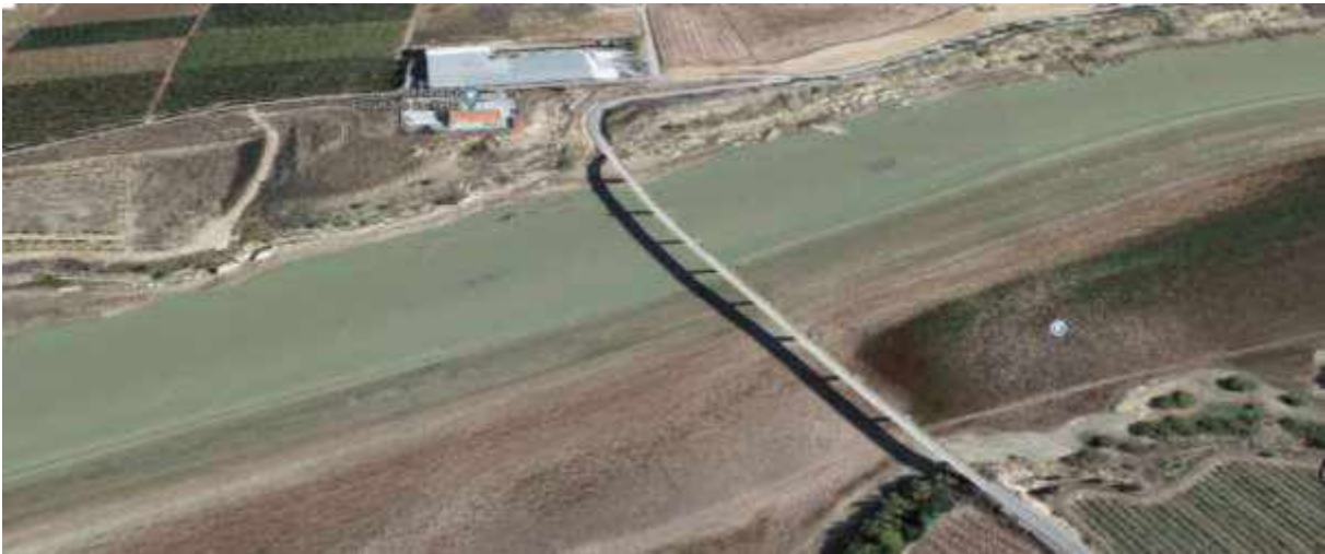
Figura 8. Puente de Chiprana. Fuente: Google Maps
