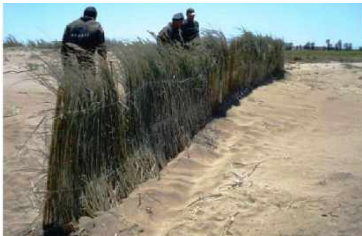
Figura 2.115: Obras en la playa de la Marquesa en 2015 (Foto: DGCM)
