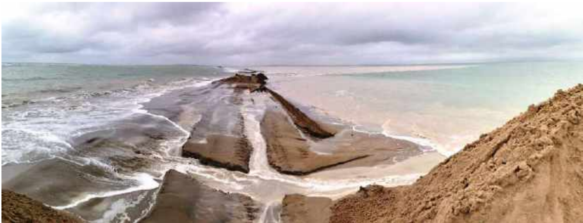
Figura 4.66: Rotura de la barra del Trabucador el 18 de marzo de 2020 cuando se estaba regenerando de la rotura sufrida en enero de ese mismo año (Foto: MITERD)
