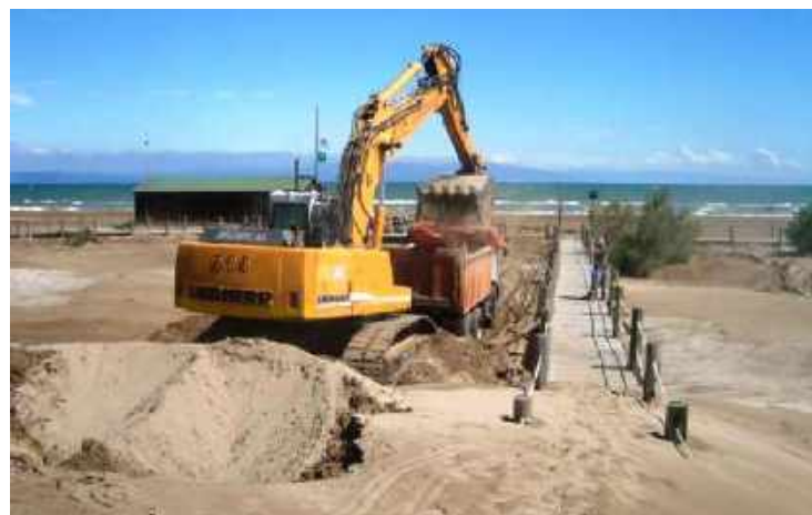
Figura 2.114: Obras en la playa de Riumar en 2015 (Foto: DGCM)
