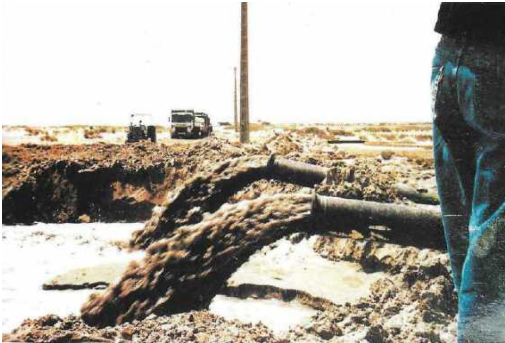
Figura 1.14: Vertido de arena para la regeneración de la Barra del Trabucador en 1991 (Fuente: Montoya y Galofré, 1997)
